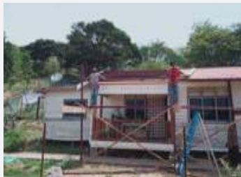
Kerja Pembaikan Bumbung
