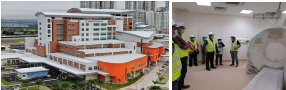
Imej 6.40 Blok Utama Hospital Cyberjaya (9 tingkat) dan Mesin CT Scanner
