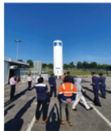
Pemasangan Micro Filling Oxygen Plant di PKRC, MAEPS
