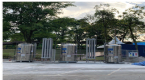
Pembinaan Pemasangan Tangki Oksigen VIE
